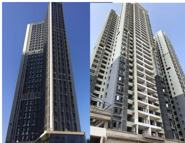
南宁东盟创客城之东地块5号楼及西地块3号楼
